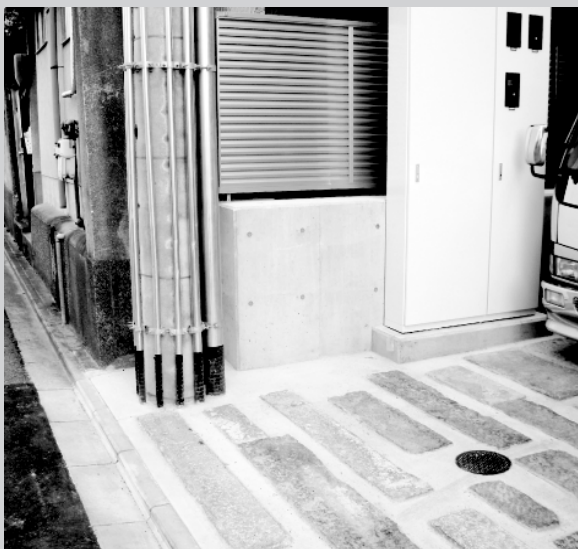
ゴミ・資源置き場 HIGOYA入口の電柱付近
